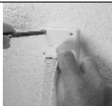
Eine Bohrung anzeichnen
