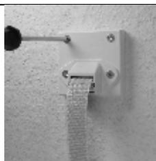
Leitrolle und Zusatzabdeckung mit 4mm Senkkopf-Spanplattenschrauben anschrauben
